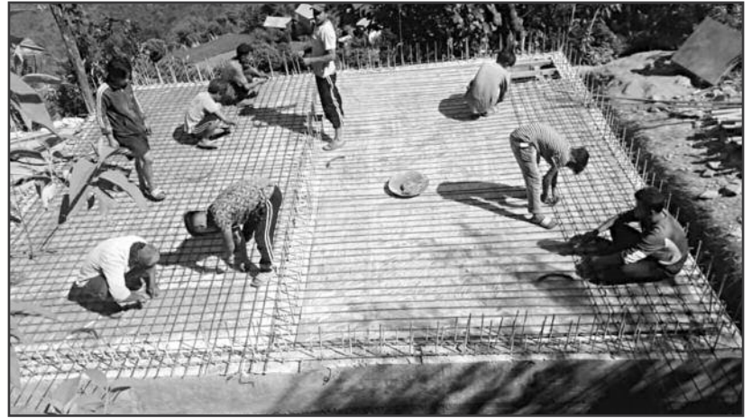
Einhemische beim Bau des Wasserreservoirs 2021.
